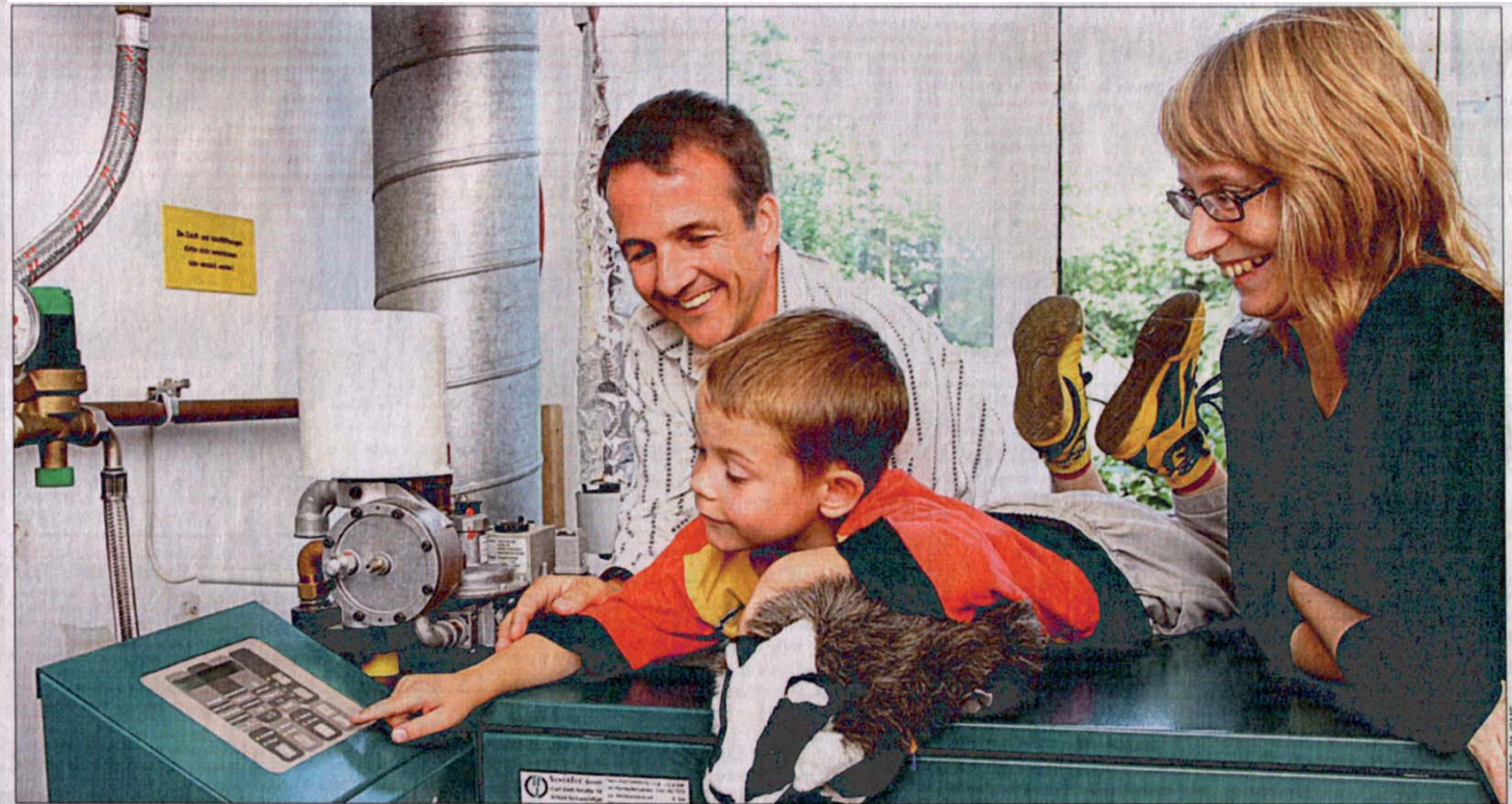
Kraftwerk im Waschmaschinen-Format: Solche Mini-Blockheizkraftwerke benötigen nicht viel Platz und ermöglichen eine sparsame Wärmeversorgung des Hauses
