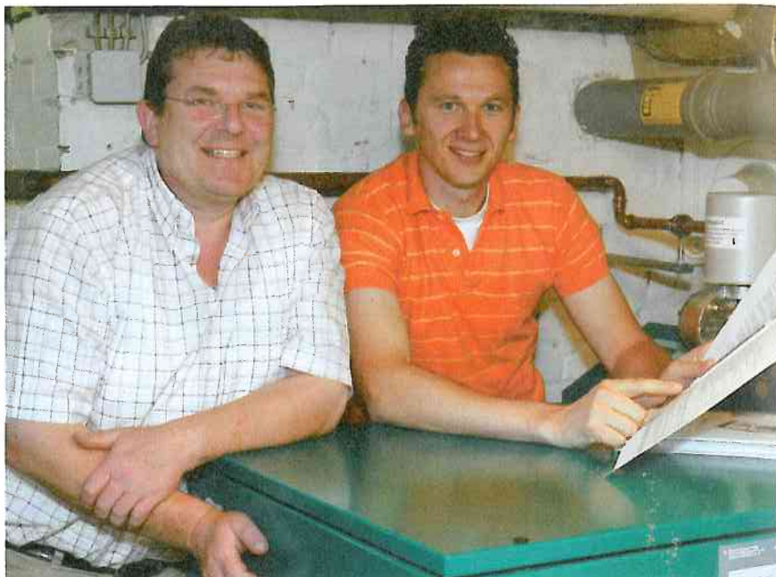
„Allesbrenner“ Dieter Quiatkowski und SHK-Installateur Alexander Stamos vor dem Mini-Blockheizkraftwerk „Dachs“ von Senertec
