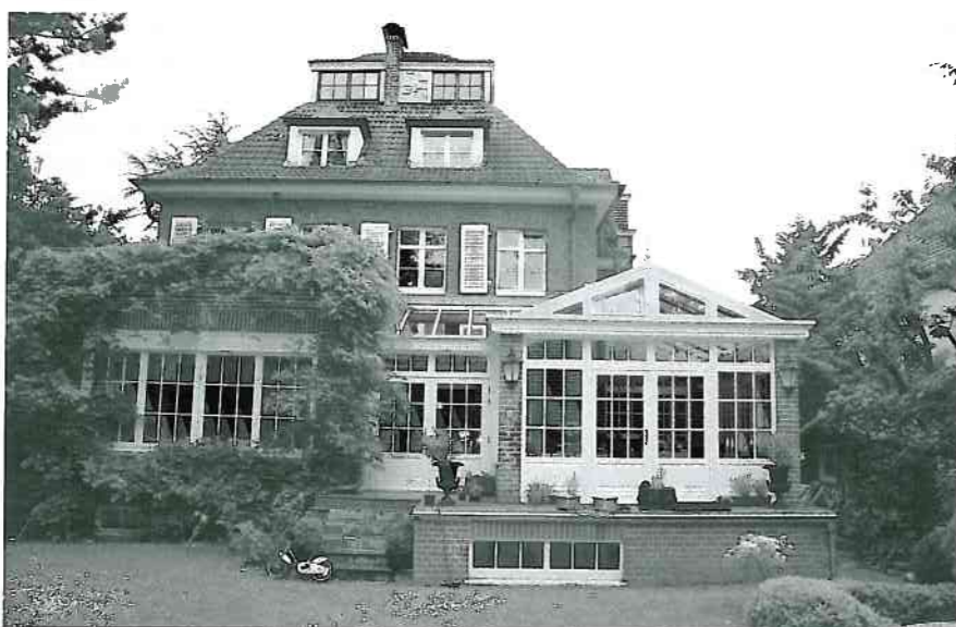
Das Einfamilienhaus mit 300 Quadratmetern Wohnfläche wird mit einem Mini-Blockheizkraftwerk mit Strom und Wärme versorgt.
