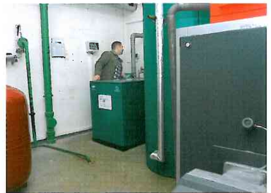
Nach viermonatiger Betriebszeit der beiden BHKW ziehen Betriebsleiterin Gisela Sierig und Planungsingenieur Peter Miesner äußerst positive Bilanz.
