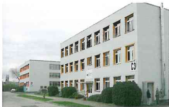
Die BHKW sorgen auf 8000 m 2 für Strom und Wärme.
